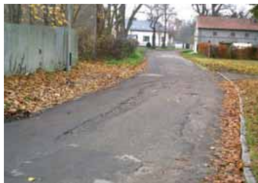
Bild 6: Wohnstraße mit Asphaltbefestigung auf Altpflaster
