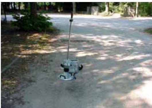
Bild 15: Tragfähigkeitsmessung mit dem Leichten Fallgewichtsgerät an einer Schwachstelle der alten sandgeschlämmten Schotterdeckschicht ( E_{vd} = 28 \text{ MN/m}^2 )
