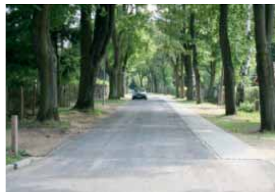
Bild 44: Ausgebaute Wohnstraße (Königs Wusterhausen)
