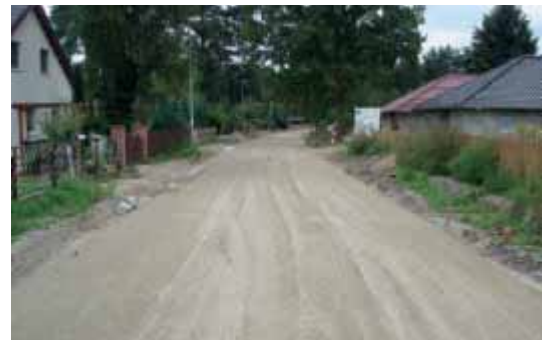
Bild 29: Herstellung einer Verfestigung (Schöneiche)
