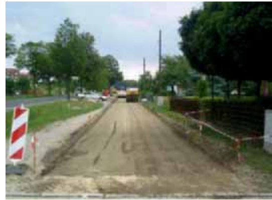
Bild 21: Verdichtung der Verfestigung vor dem Einbau der Schotterzwischen-schicht 0/22
