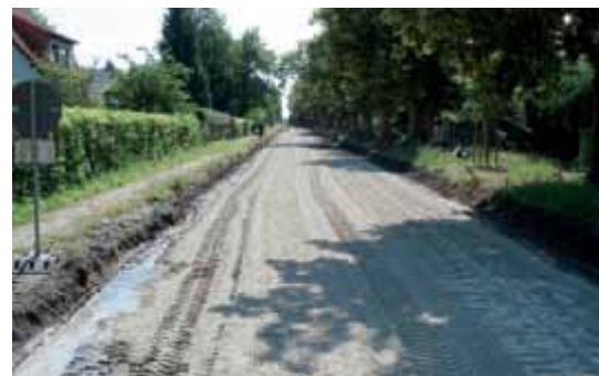
Bild 31: Herstellung einer Zementverfestigung (Neuenhagen)
