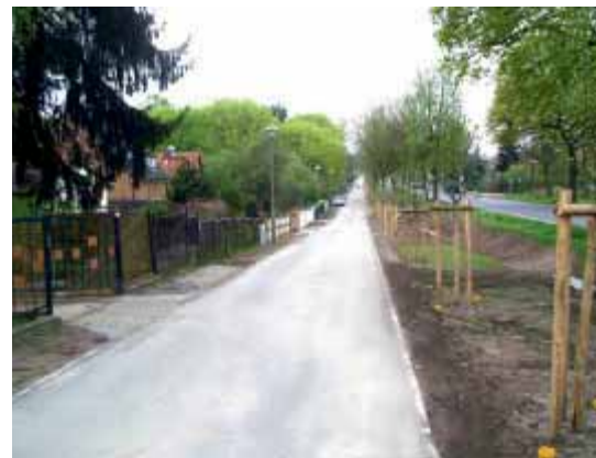
Bild 22: Nach Erneuerungsvariante E-Var. 4 erneuerte Wohnstraße mit 20 cm Verfestigung, 8 cm Schotterzwischen-schicht 0/22 und 10 cm Asphalt
