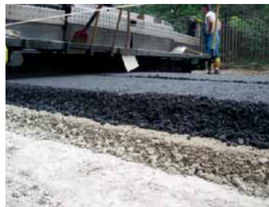
Bild 23: 8 cm dicke ungebundene Zwischen-schicht 0/22
