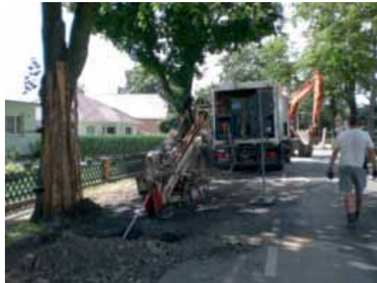
Bild 39: Baumschutzmaßnahmen
