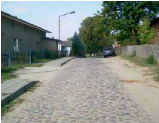
Bild 2: Wohnstraße mit Pflasterbefestigung vor dem Ausbau
