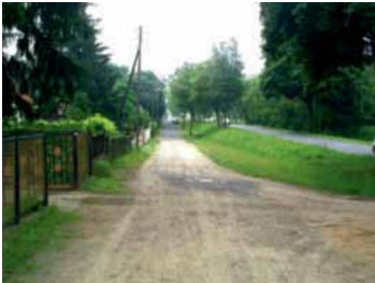
Bild 18: Vorhandene ungebundene Straßenbefestigung vor der Verfestigung
