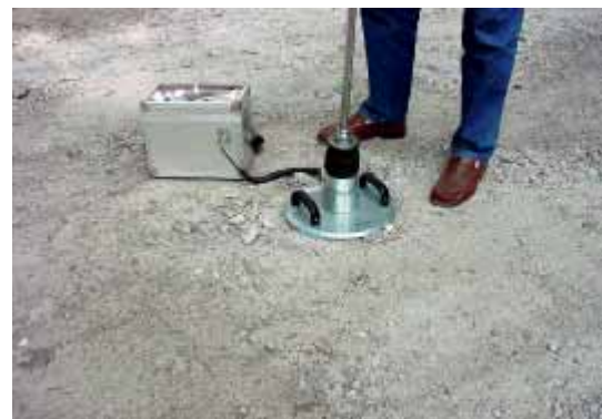
Bild 17: Tragfähigkeitsmessung mit dem Leichten Fallgewichtsgerät in einem Schlagloch der alten sandgeschlämmten Schotterdeckschicht nach der Verfüllung mit standfestem RC-Material ( E_{vd} = 120 \text{ MN/m}^2 )
