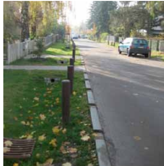
Bild 13: Offene Entwässerung (Birkenwerder)
