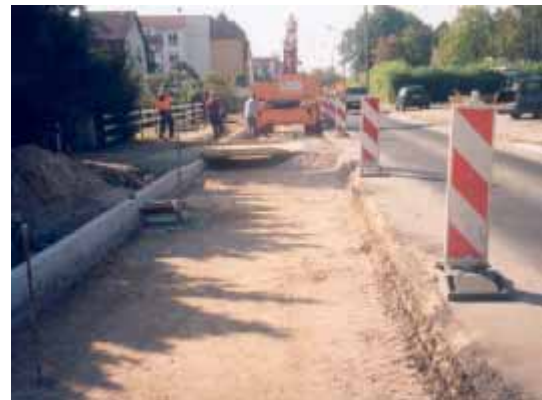
Bild 36: halbseitige Bauweise
