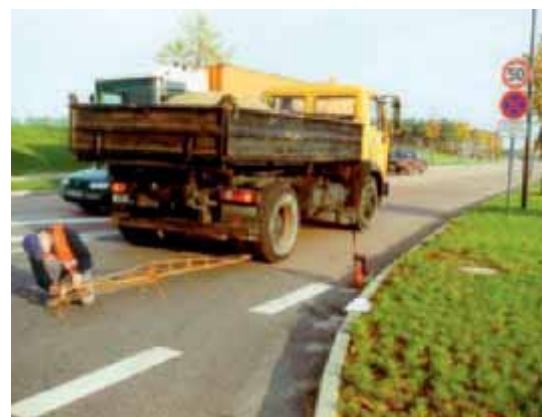
Bild 12: Einsenkungsmessung mit Benkelman-Balken an der Fuge einer Betonbefestigung
