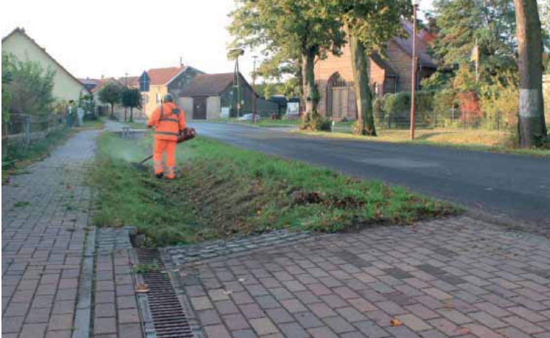
Bild 42: Pflege der Entwässerungsanlagen
