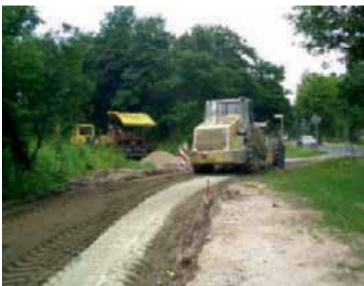
Bild 20: Durchführung der Verfestigung im Mixed-in-place-Verfahren
