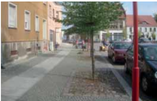
Bild 17: Gut gestalteter neuer Seitenraum (Doberlug-Kirchhain)
