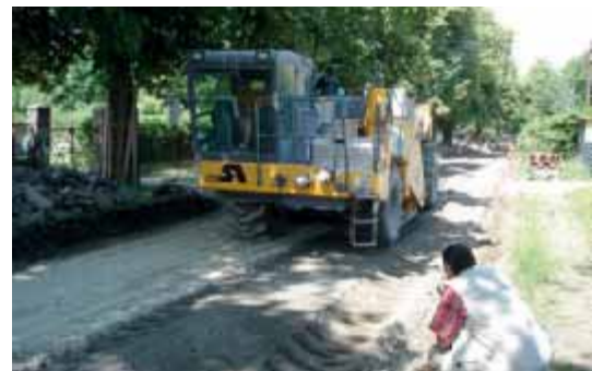
Bild 30: Herstellung einer Zementverfestigung (Neuenhagen)
