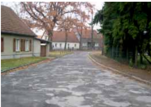
Bild 5: Wohnstraße mit alter Asphaltbefestigung
