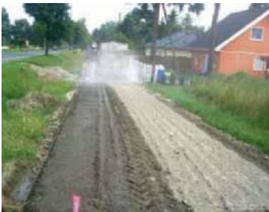
Bild 19: Bindemittelverteilung für die Verfestigung
